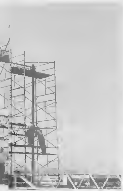
erect steel columns and beams. ut gi columna y biganan di staa.
